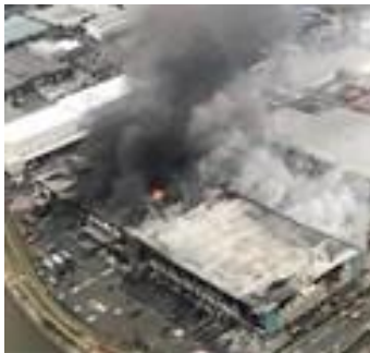
【令和2年4月宮城県岩沼市で発生した 大規模物流倉庫火災】
