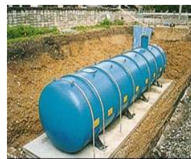
【耐震性貯水槽】
